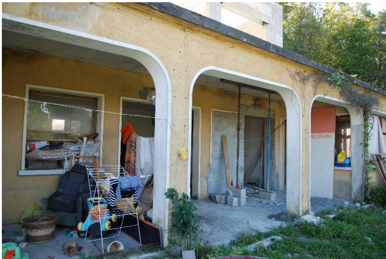
Vue partielle des locaux de l'ancienne école.
