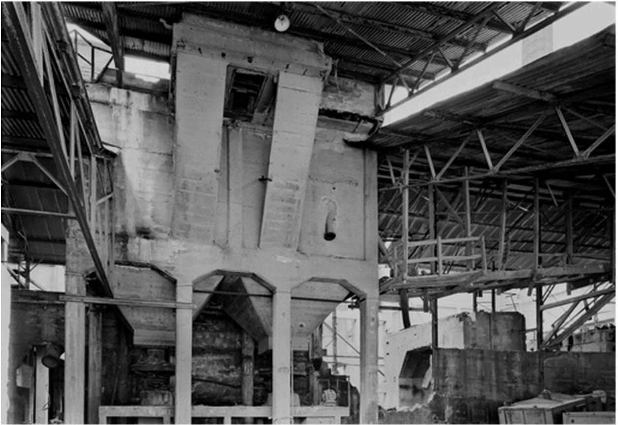
Vue intérieure des locaux
