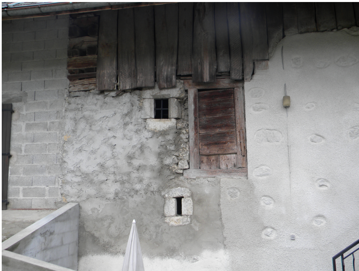
Détail d'encadrement chanfreinés en façade ouest.
