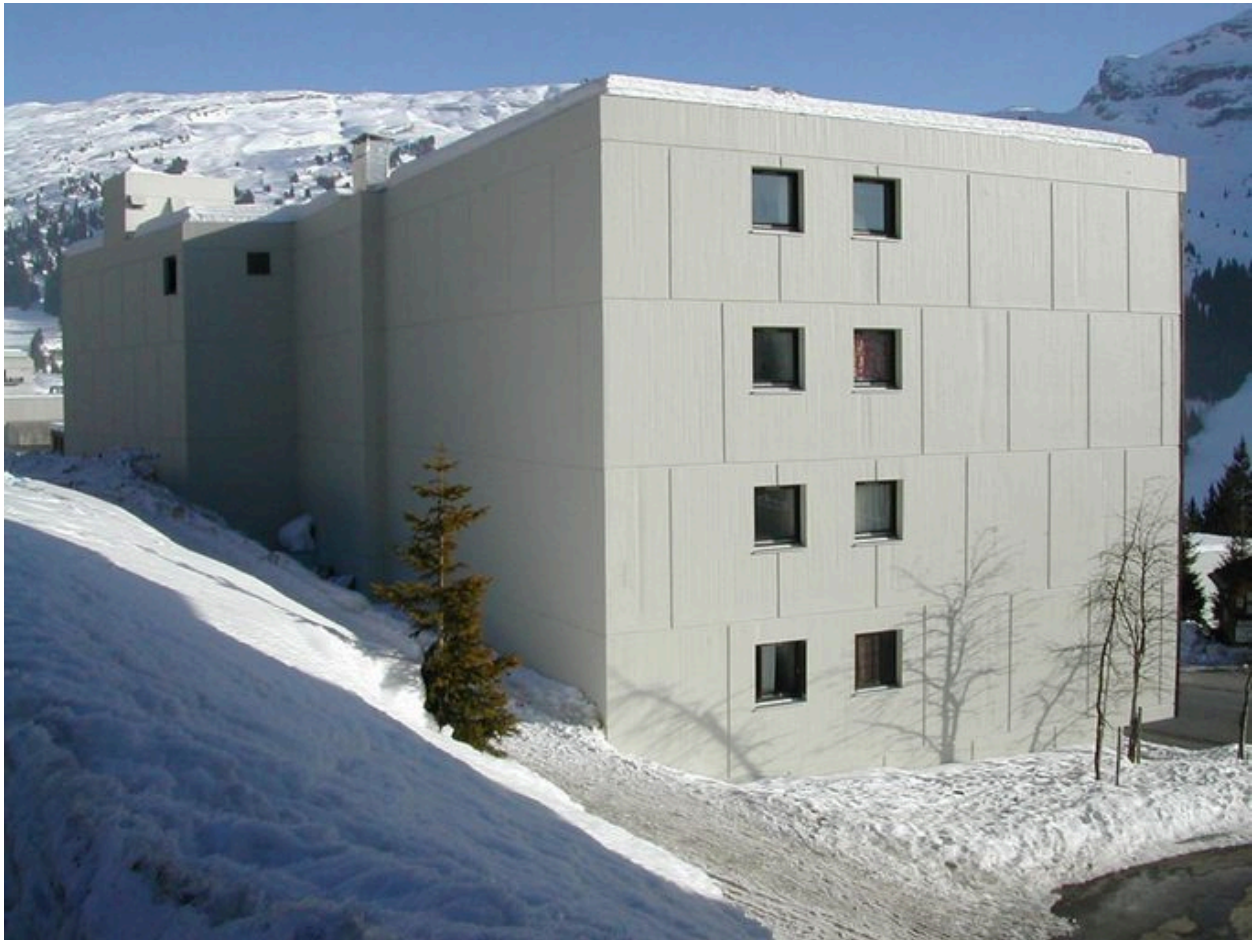
Élévation postérieure et pignon ouest
