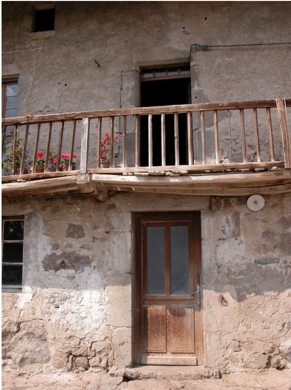
Détail de la façade du logis : portes d'entrée.
