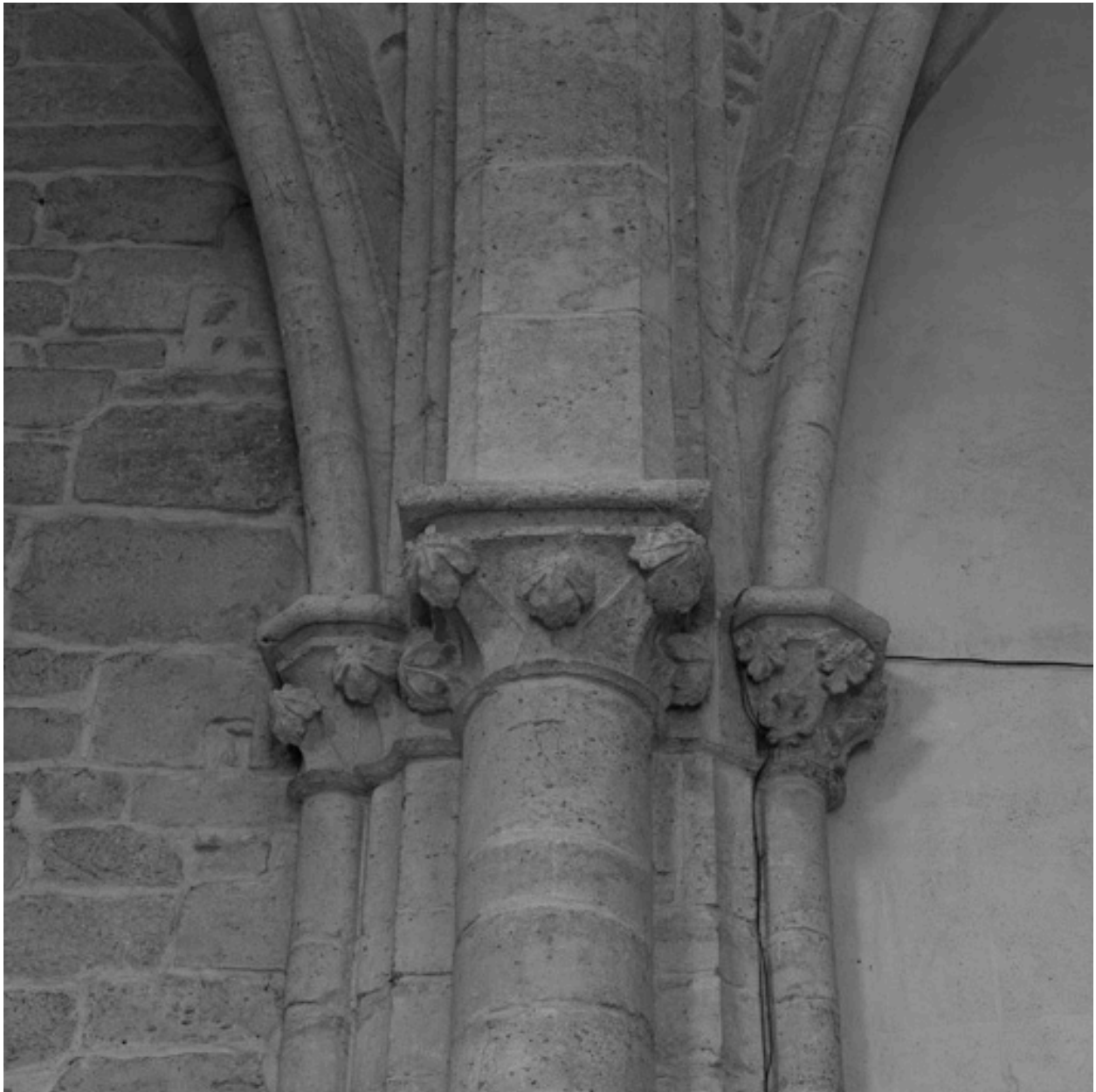
Détail de chapiteaux : support entre les travées VI et VII, bas-côté sud (?).
