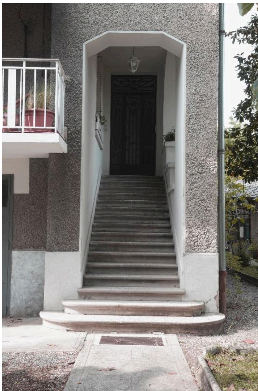
Porche, escalier et porte d'entrée
