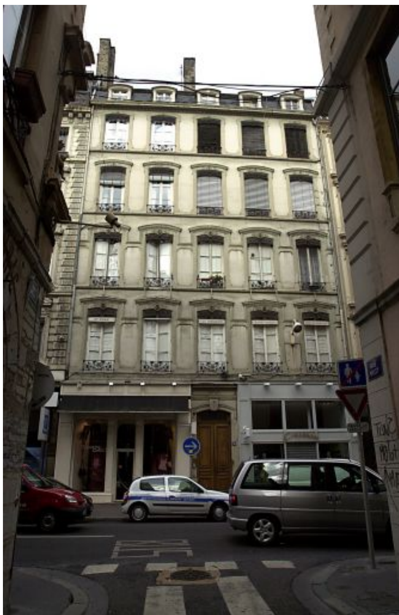
Façade sur rue, vue générale
