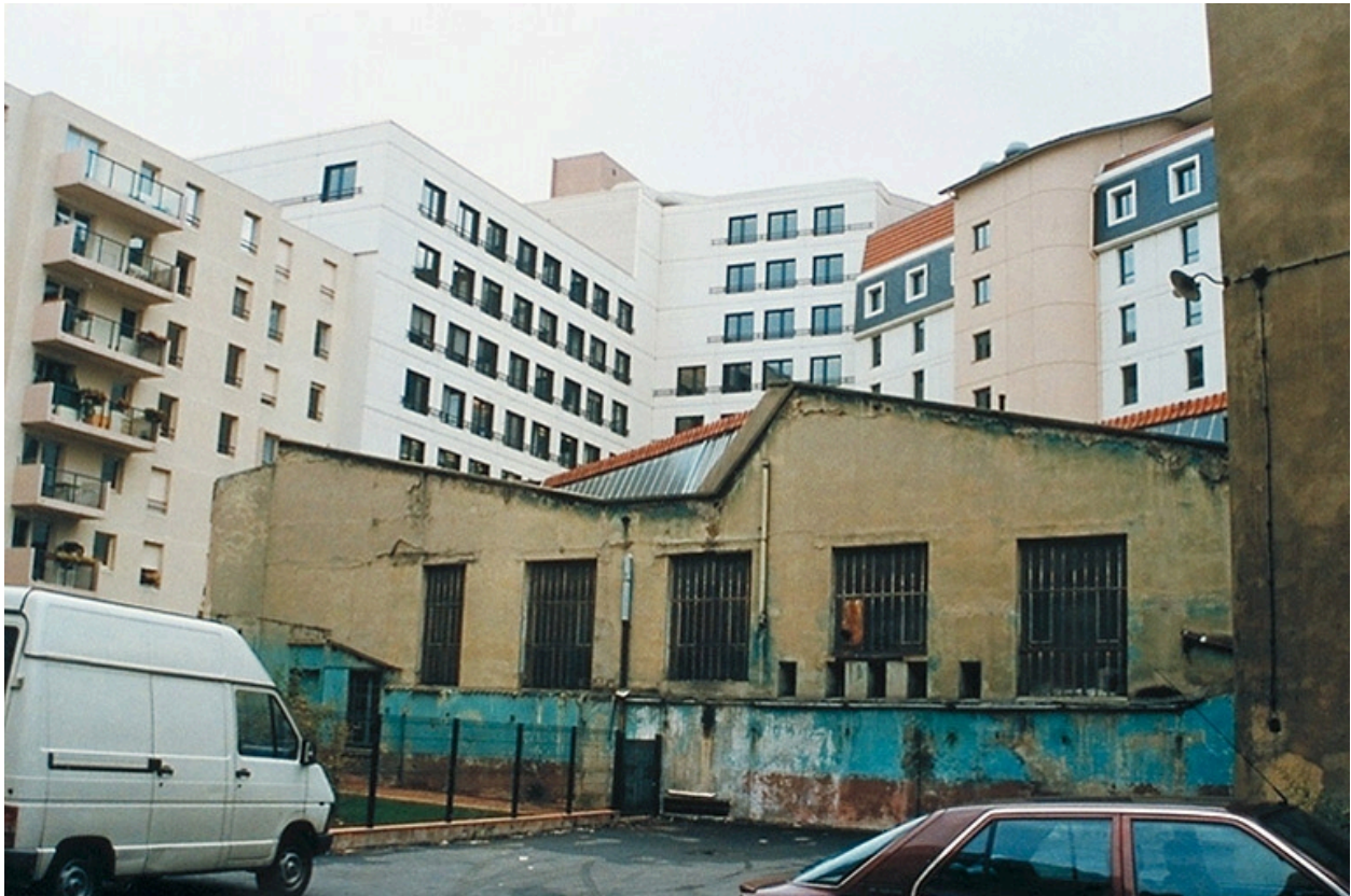
Vue d'ensemble avant réhabilitation
