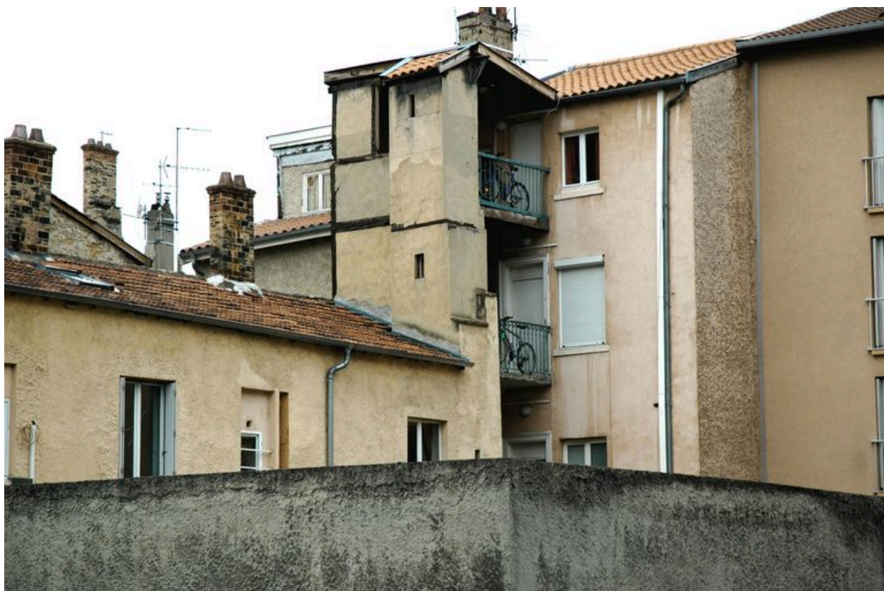
Aperçu de la partie supérieure du mur nord vu depuis le nord-est
