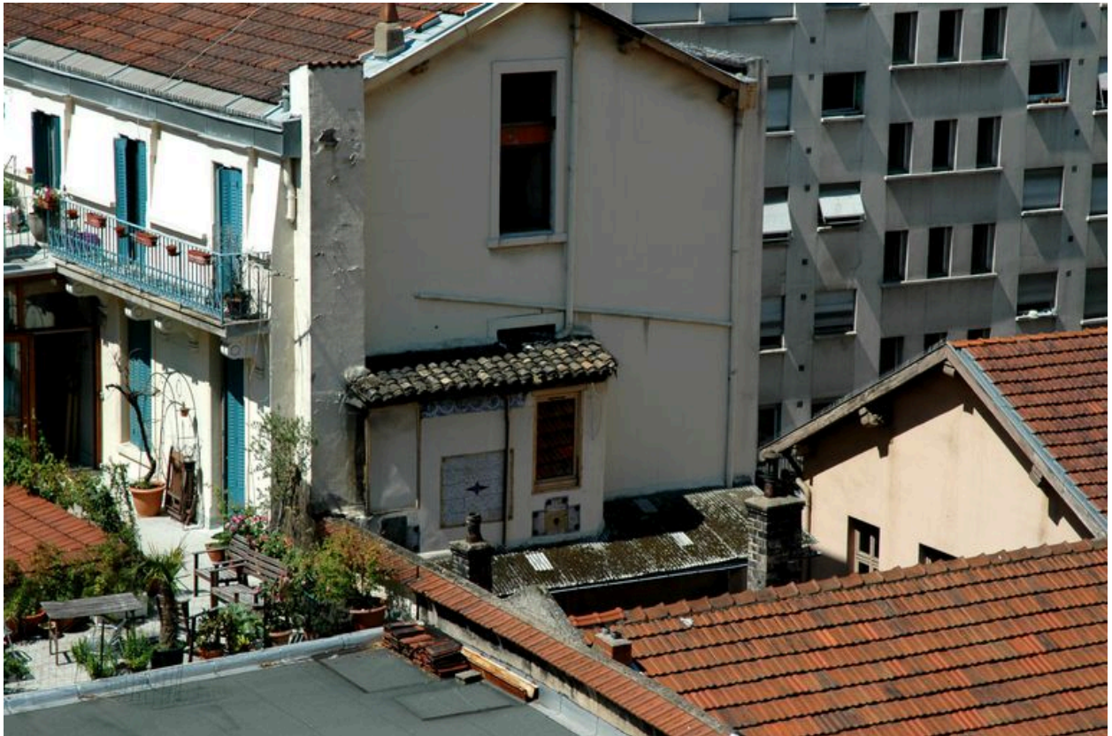
Vue d'ensemble du pignon nord
