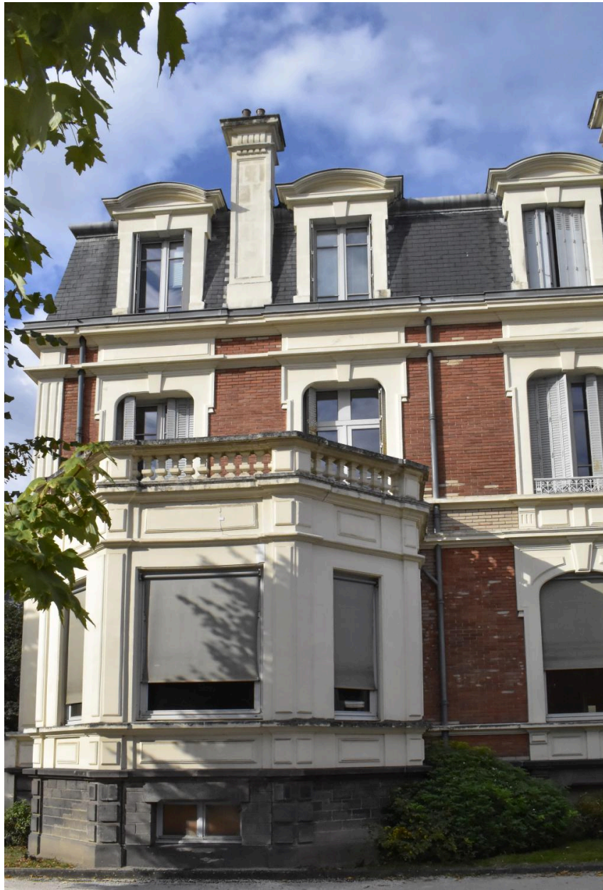
Elévation orientale, bow-window couronné d'une terrasse
