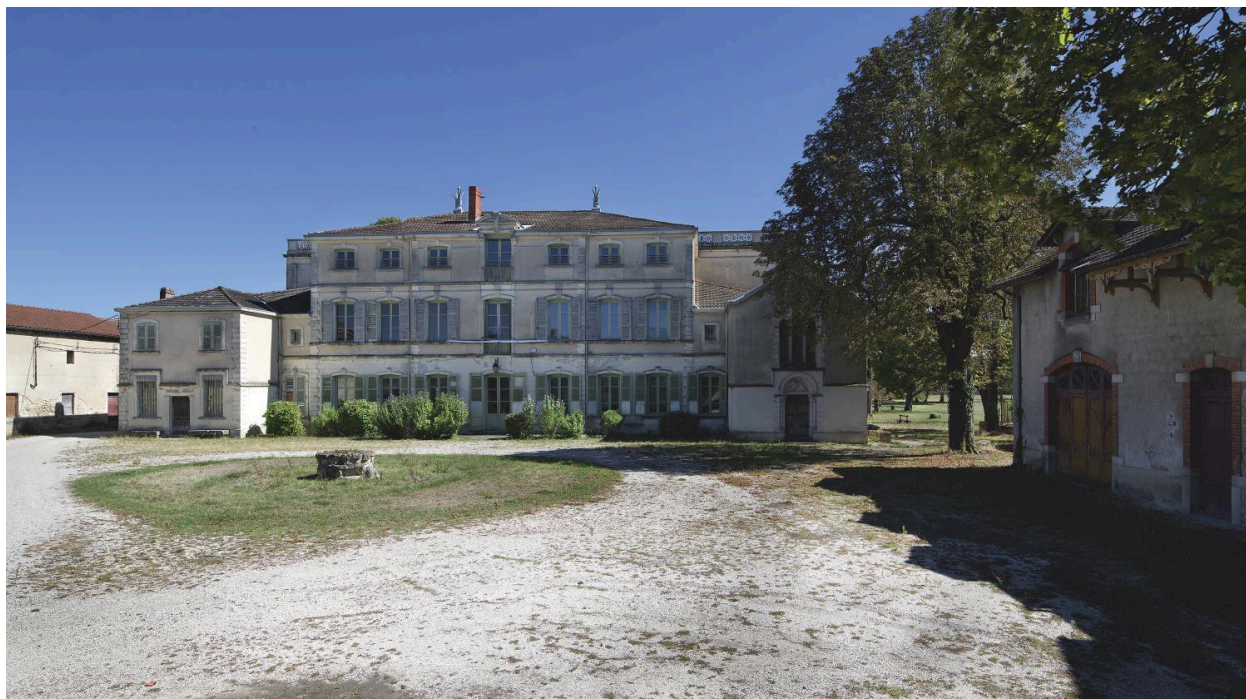
Façade ouest, vue générale
