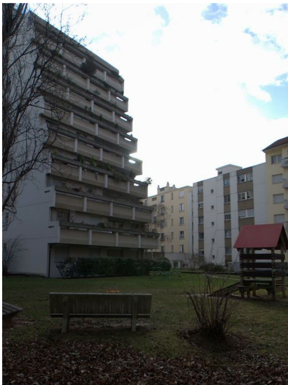
Elévation ouest du corps de bâtiment sud, depuis le nord-ouest
