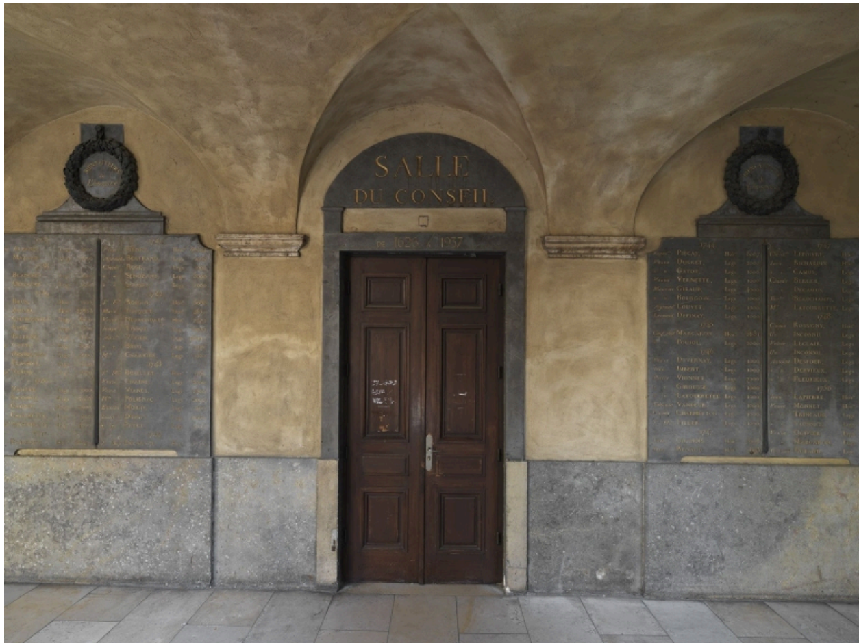
Bâtiment M. Porte de la salle du Conseil, galerie est de la cour d'Honneur
