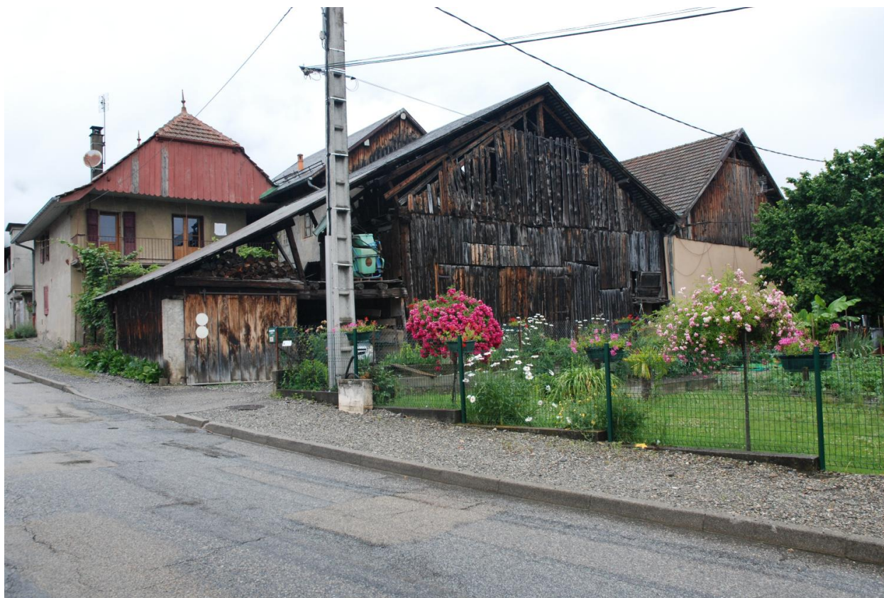
Vue des remises 2018 D2 1720 et de l'habitation 2018 D2 302.
