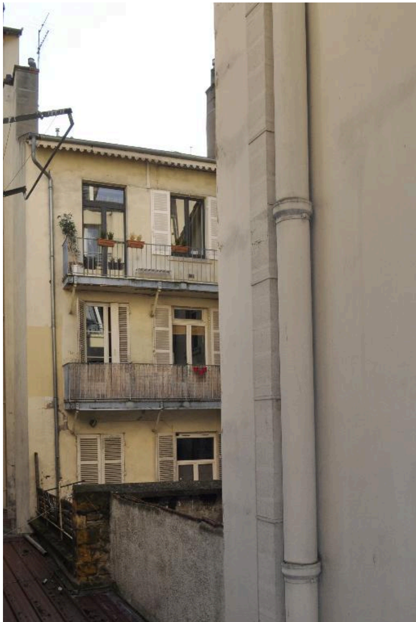
Elévation sur cour, vue partielle avec coursières
