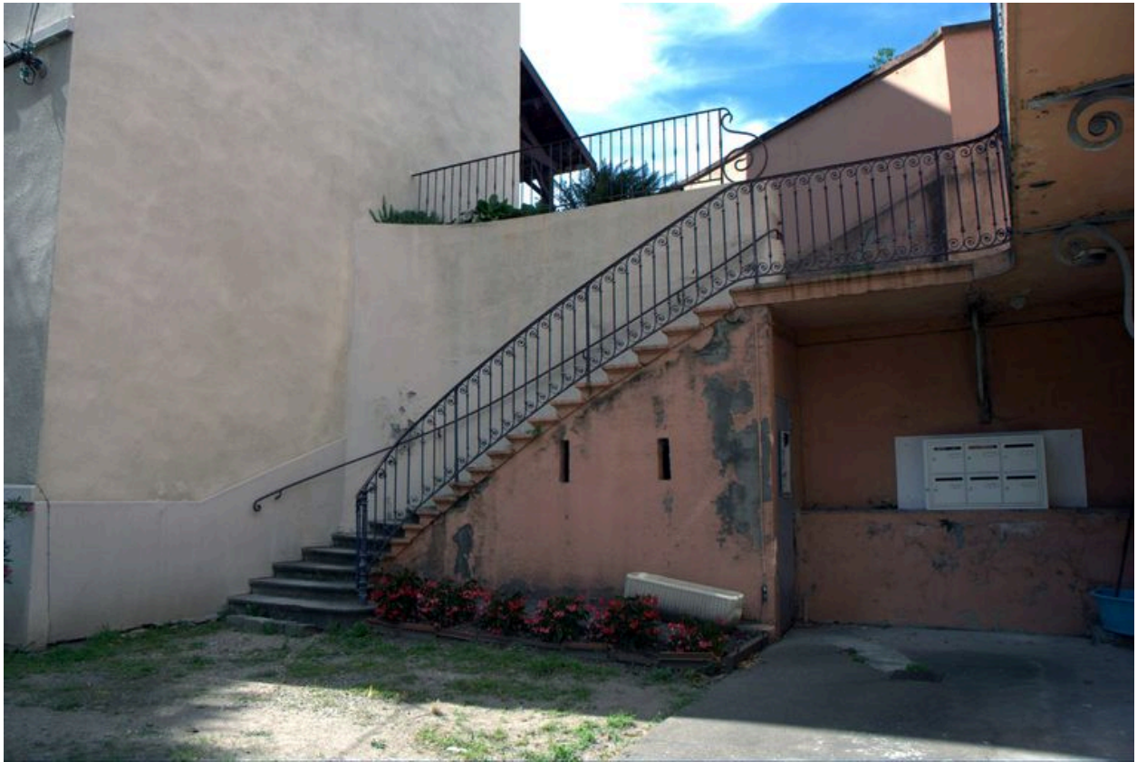
Escalier extérieur conduisant au premier étage
