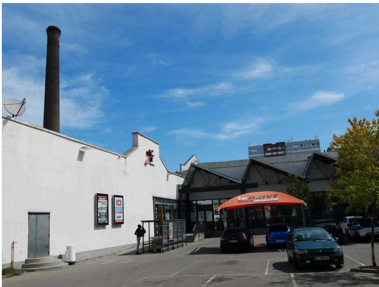
Vue pignon et cheminée
