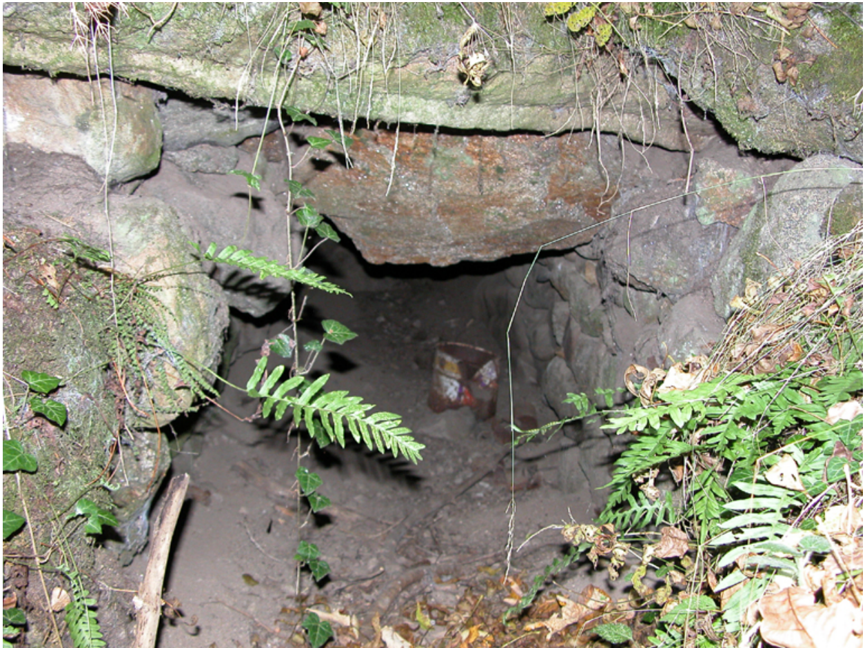
Canalisation du bief.
