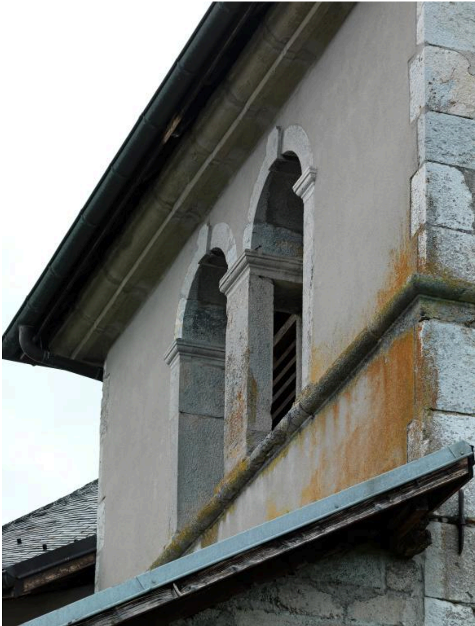
Détail des baies du clocher.
