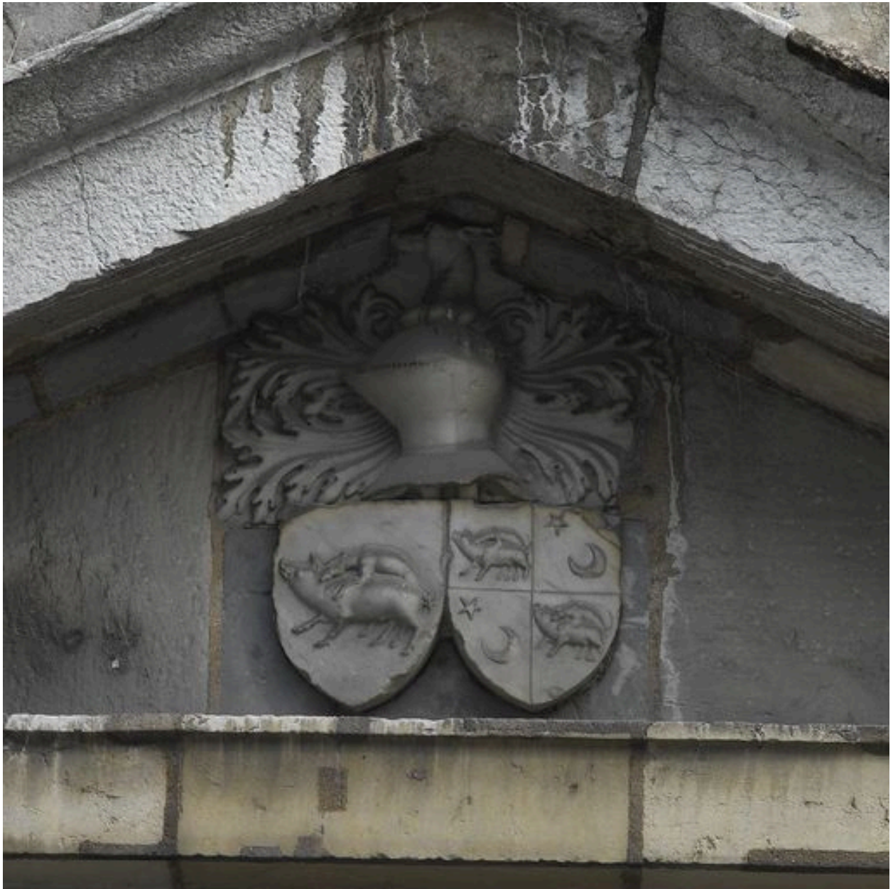
Portail principal, détail des armoiries du fronton
