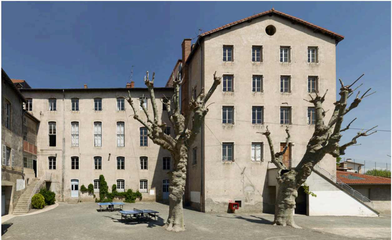
Bâtiments B et C, vue des élévations depuis la terrasse inférieure.
