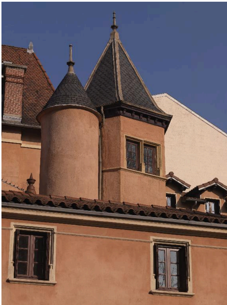
Détail des tourelles, depuis l'ouest.
