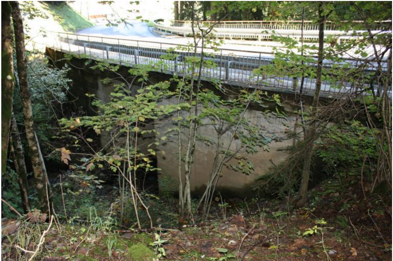
Pont de la Panosse, vue amont
