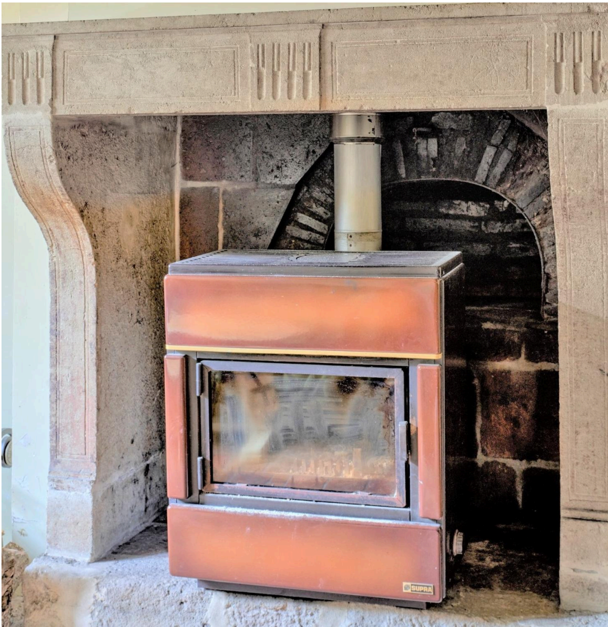
Détail du foyer de la cheminée à l'ouest du bâtiment sud contenant la porte du four à pain.
