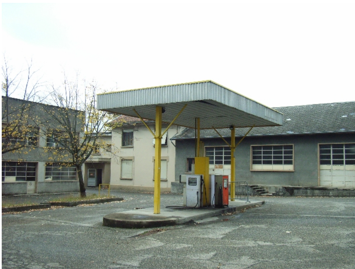
Station de carburant, première cour
