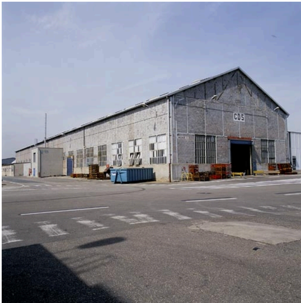
Bâtiment CD5, débitage de bobines de tôles, 20 tonnes, ligne de cisailage automatique, étude cabine, avenue C.
