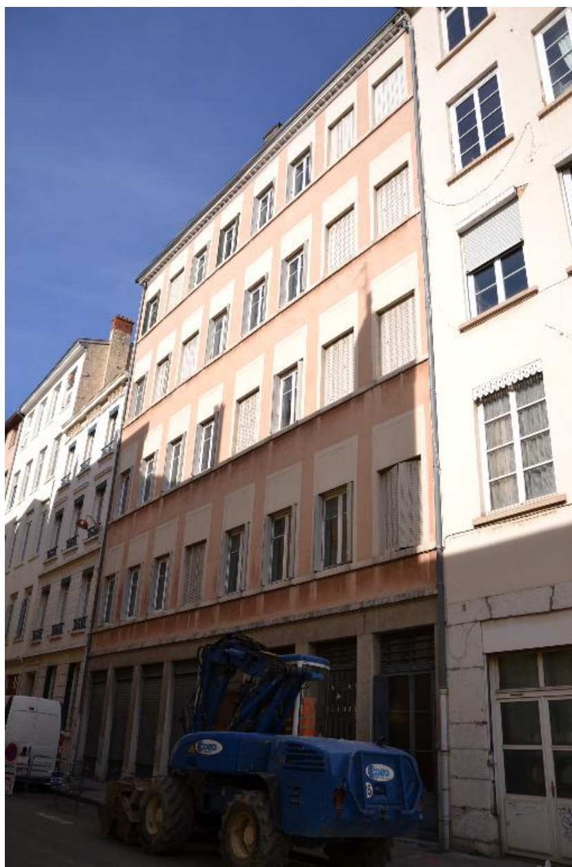
Vue d'ensemble façade sud
