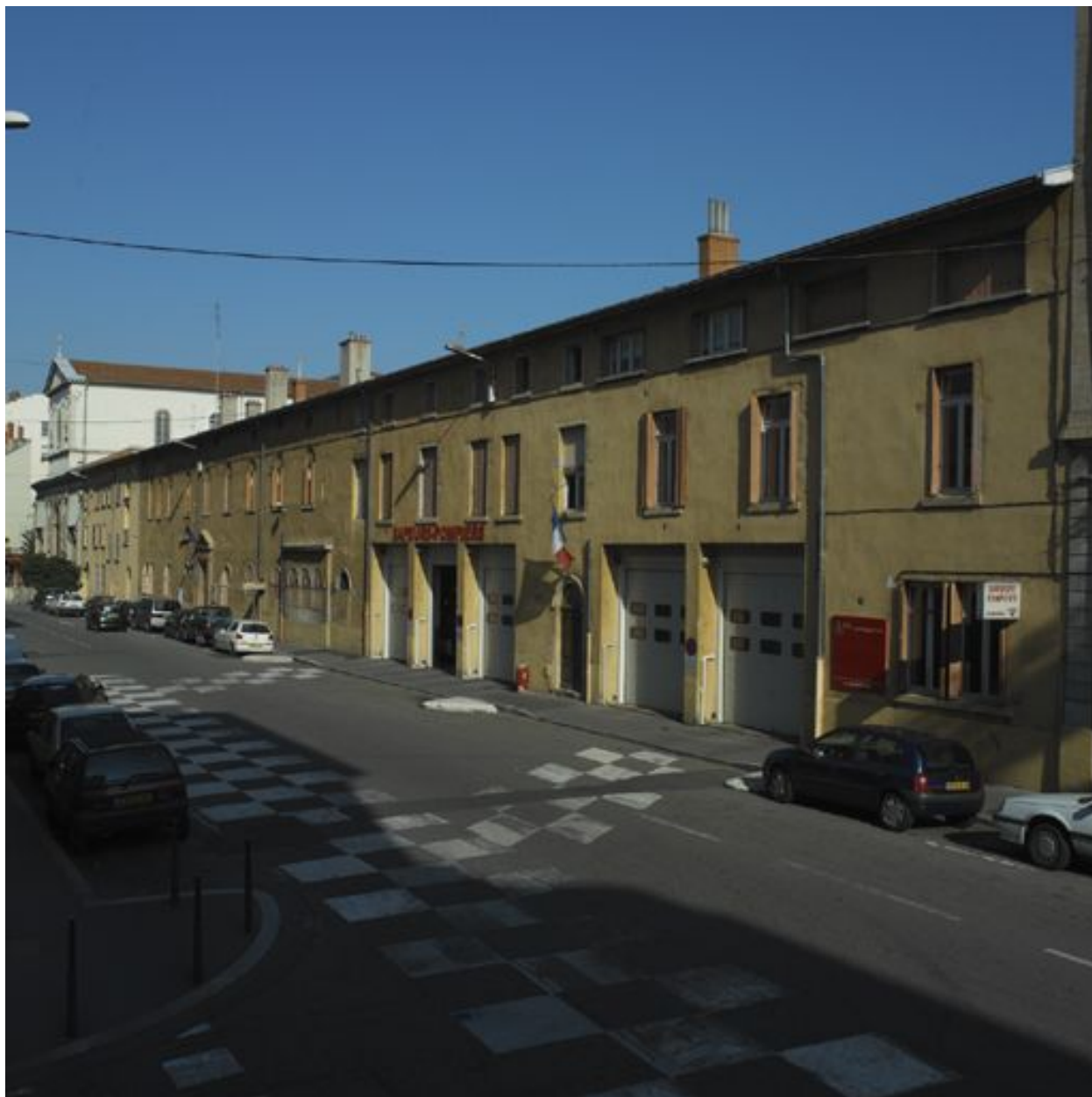
Elévation rue de la Madeleine
