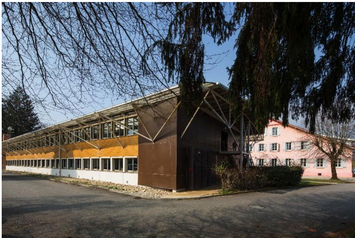
Bât. B : vu depuis le sud-ouest
