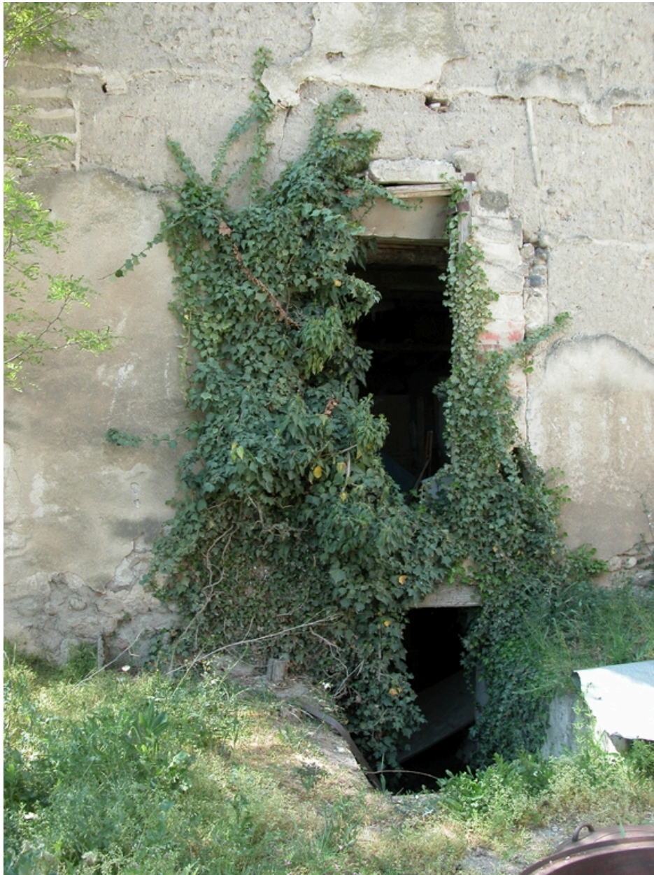
Détail de l'entrée de la cave et du rez-de-chaussée.
