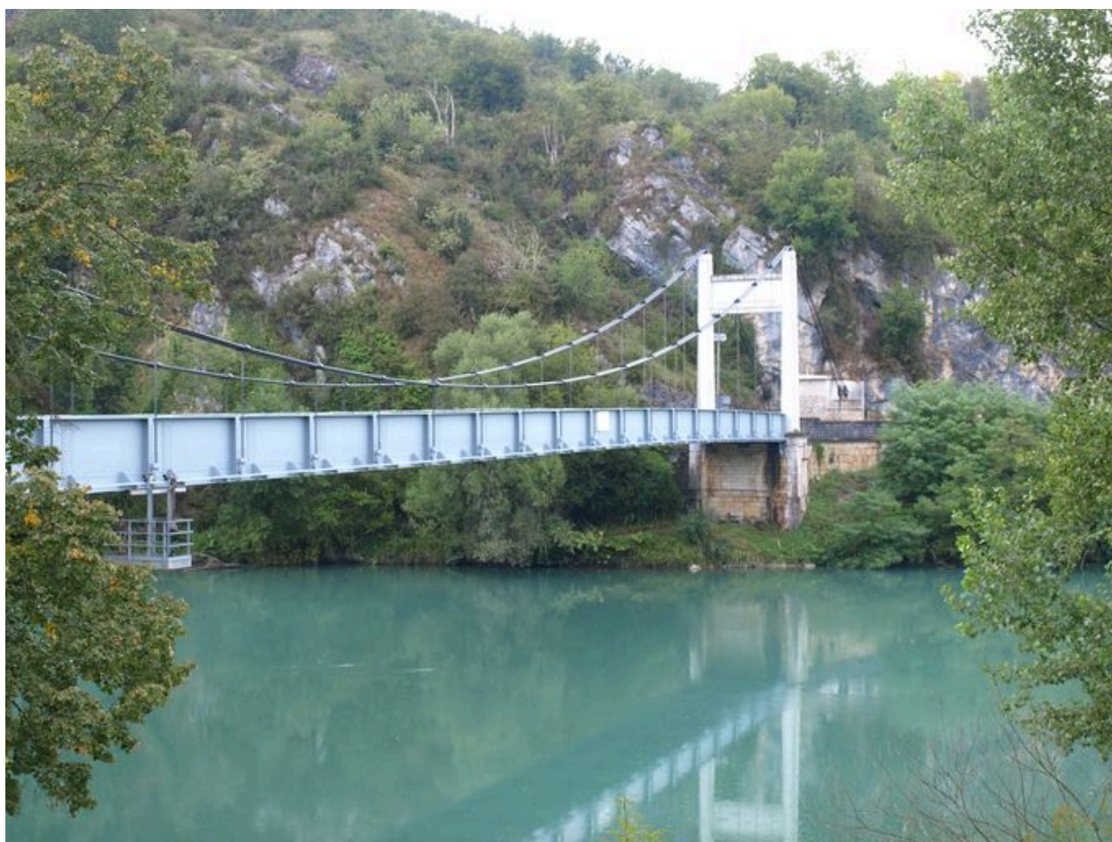
Vue partielle, face amont (depuis la rive gauche)
