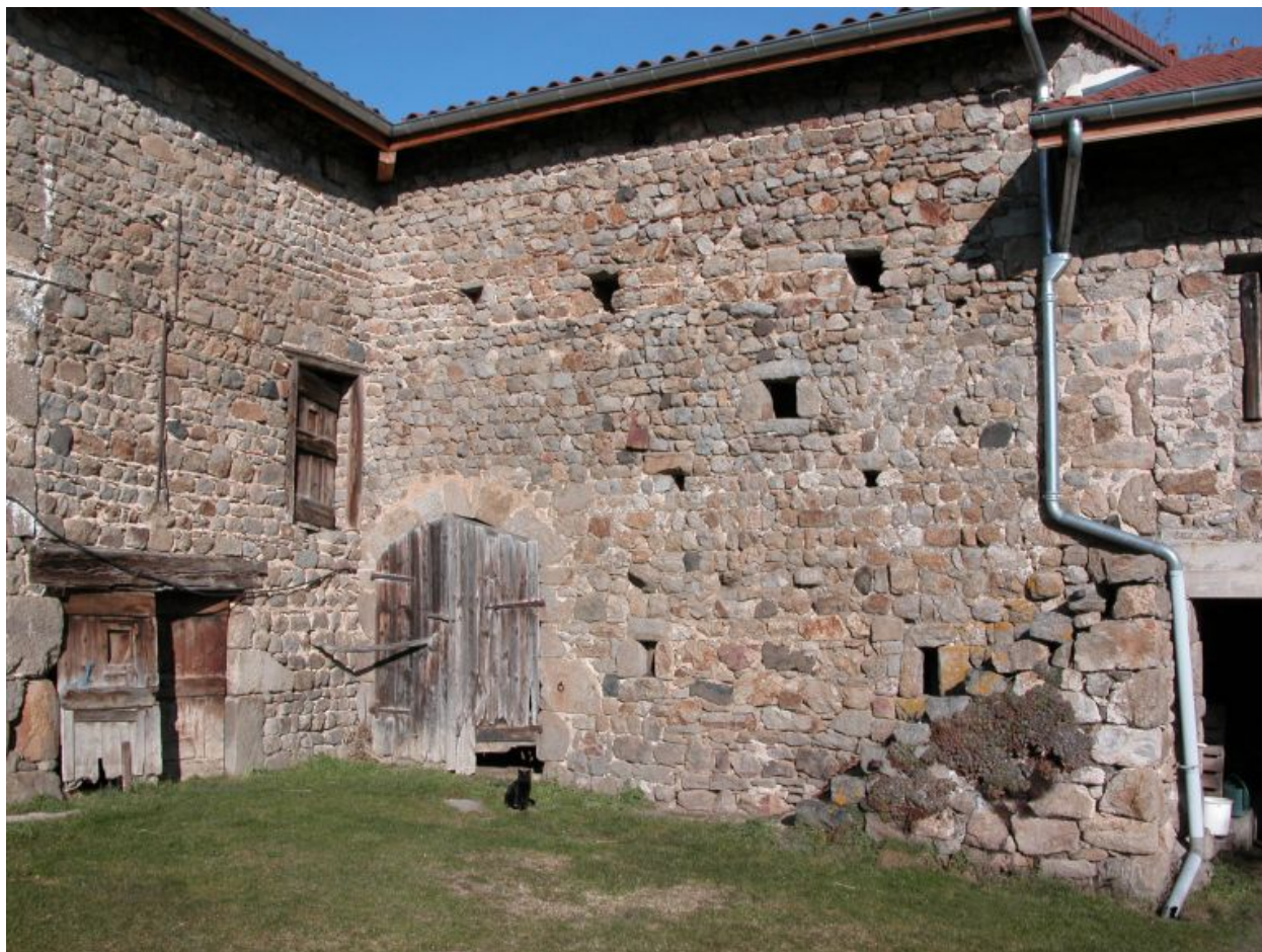
Vue d'ensemble de la liaison des deux corps de bâtiments de la ferme.
