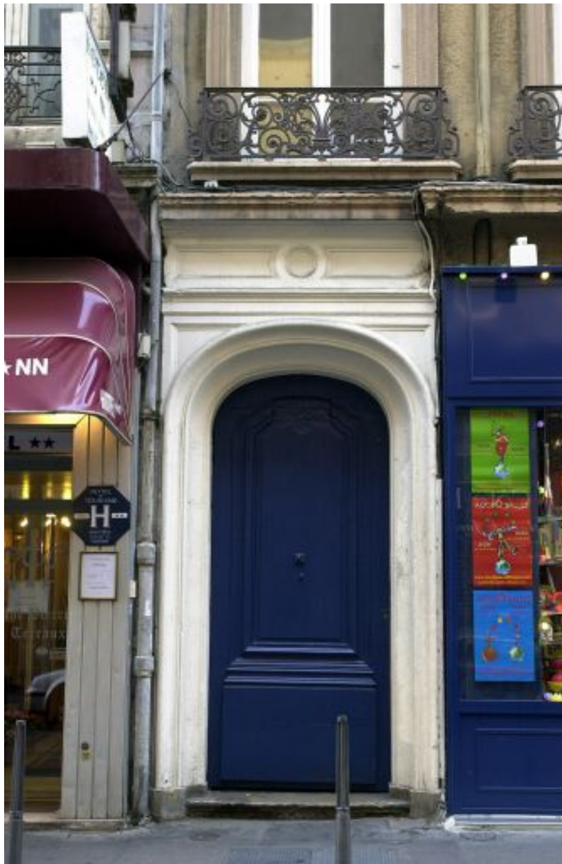
Façade sur la rue Paul-Chenavard, détail de la porte
