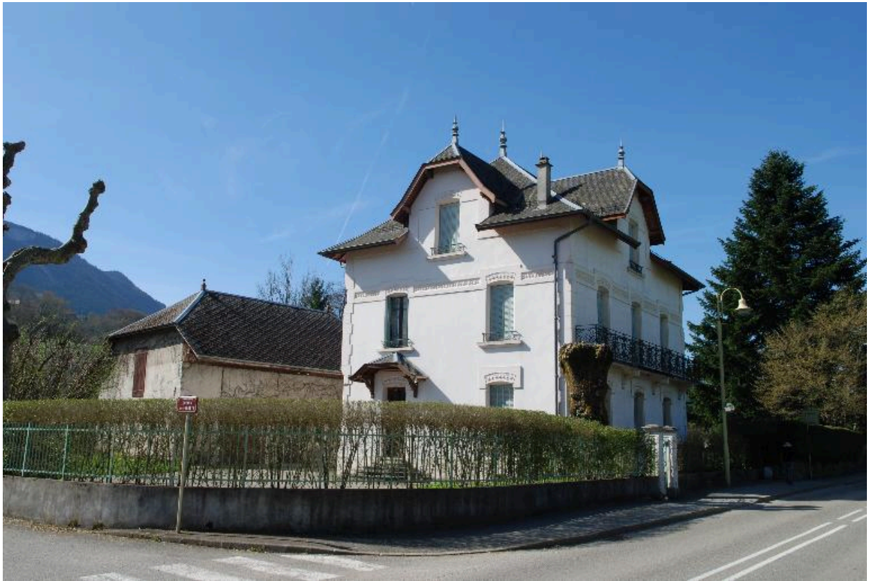
Vue d'ensemble de la villa de trois-quarts nord-est.
