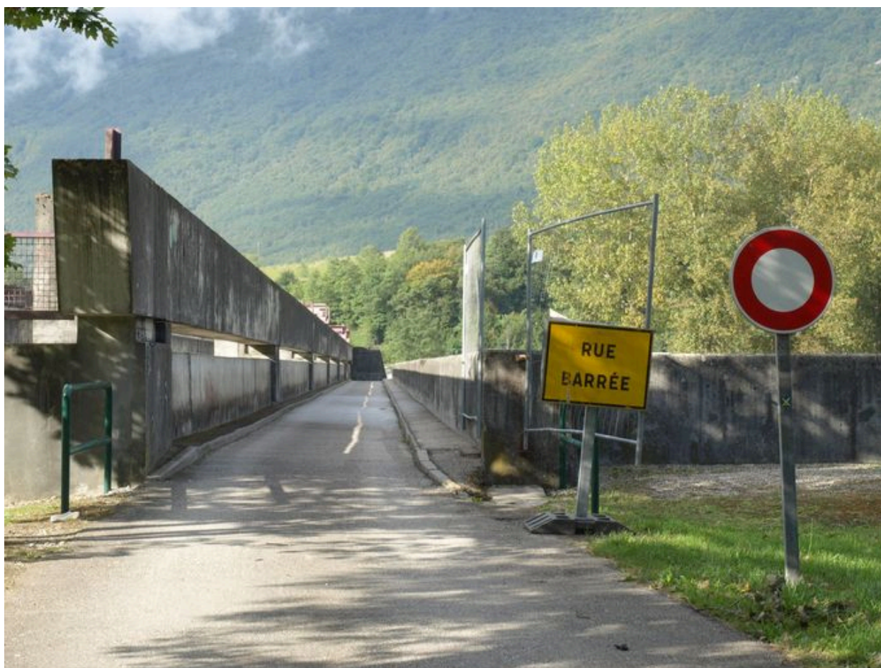
Vue du pont
