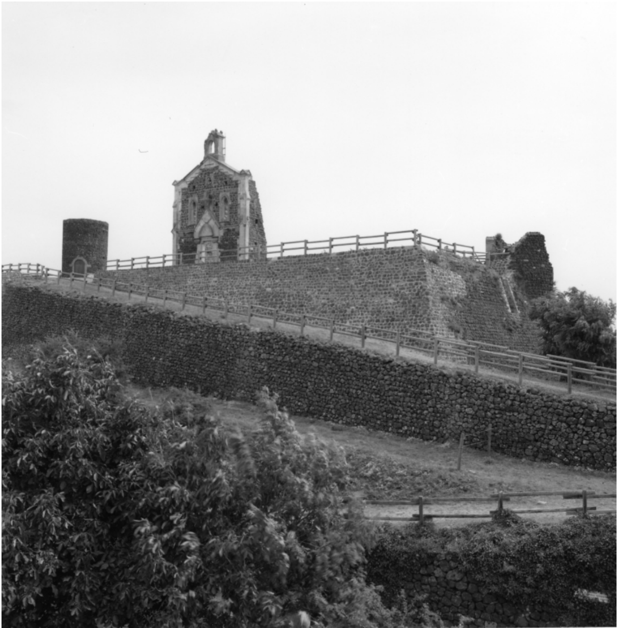
Vue des côtés ouest et sud de la cour haute du château : chapelle, rampes, deux tourelles d'angle - nord-est et sud-est - du glacis, depuis le sud-ouest.
