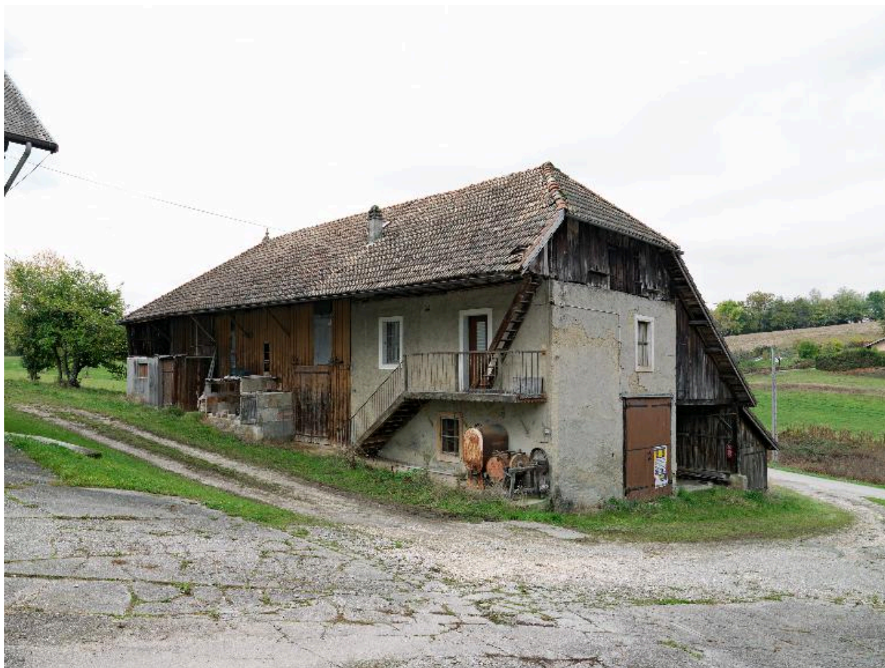
Vue d'ensemble du bâtiment nord.
