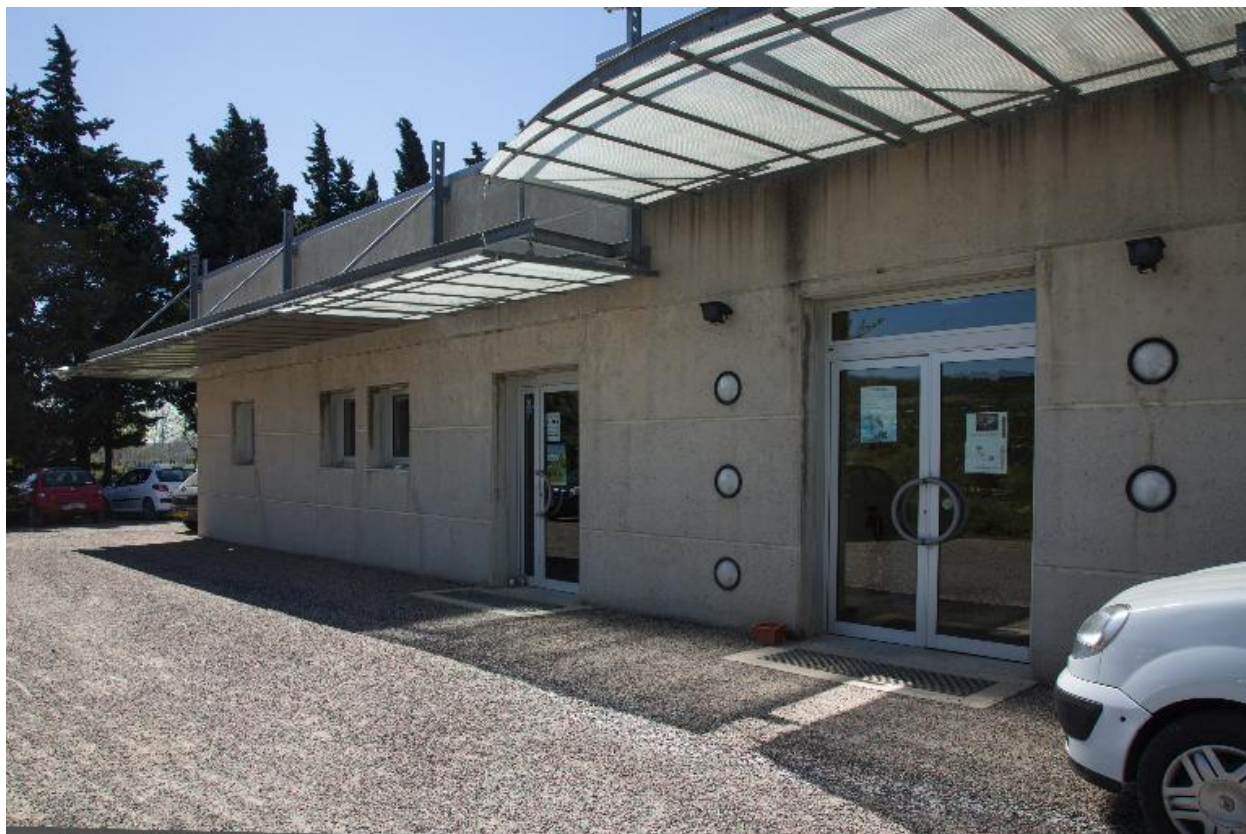
Station de grainage : façade ouest, entrée
