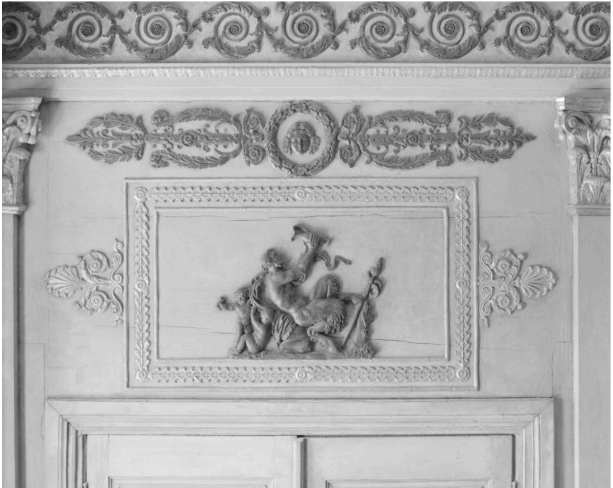
Premier étage. Salle neuve. Décor de l'ancienne poste de Crest. Un dessus de porte représentant un Satyre buvant et des amours.
