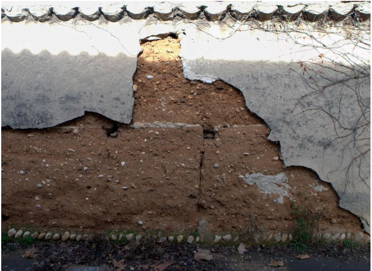
Détail du mur en pisé
