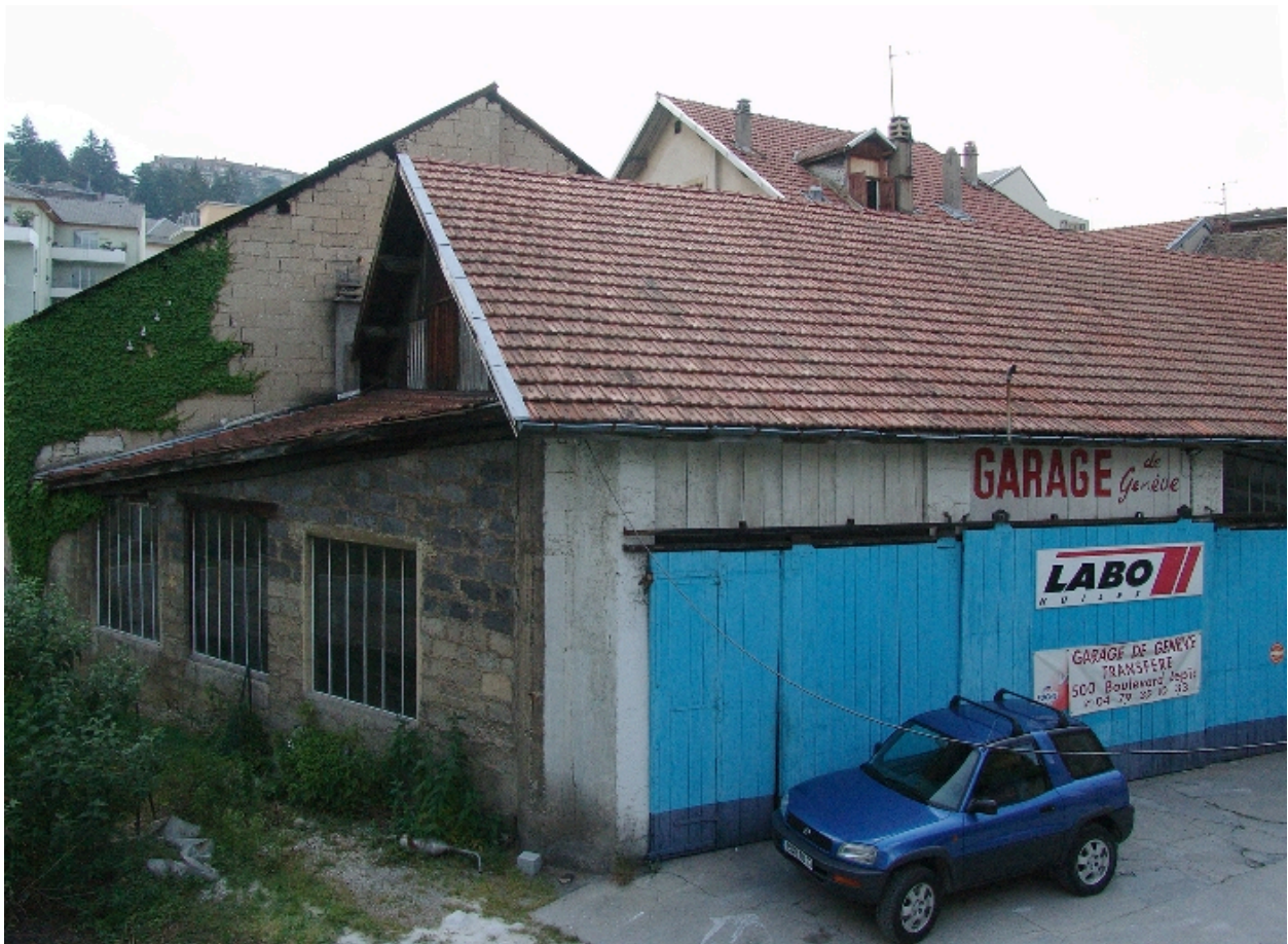
Garage de réparations automobiles : vue de trois-quart
