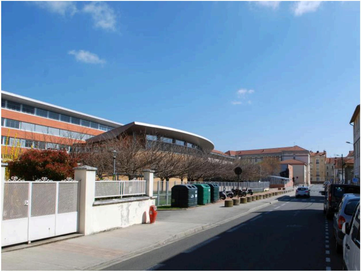
Vue générale depuis l'est
