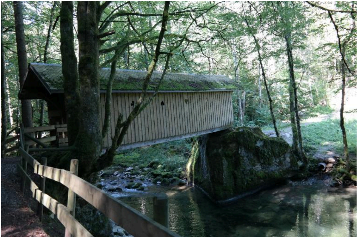
Pont couvert de Bellevaux, vue de la face aval
