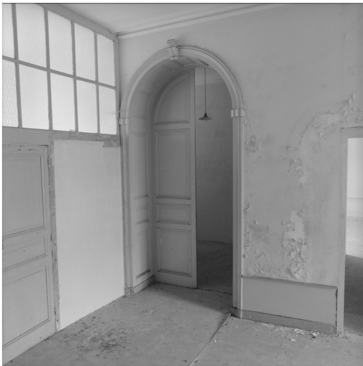
Vue intérieure du couloir du premier étage, encadrement de porte en plein cintre.
