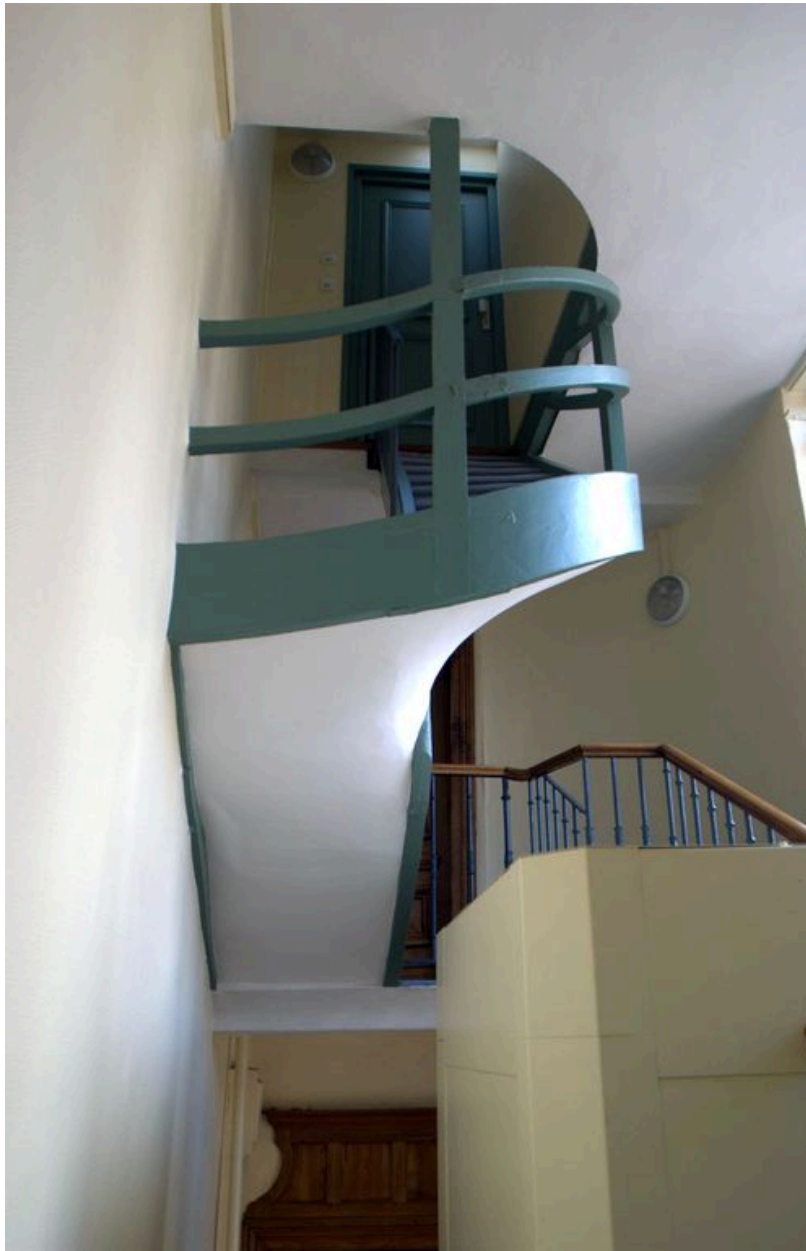
Vue de la dernière volée de l'escalier, en bois
