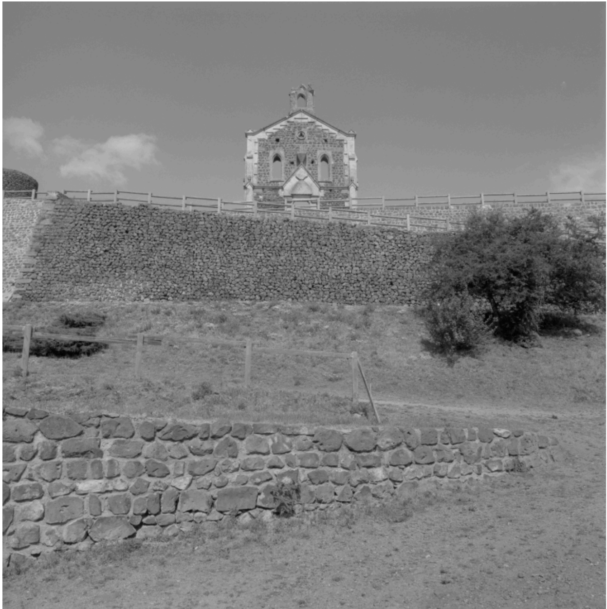
Vue du côté ouest de la cour haute du château : façade de la chapelle et rampes d'accès depuis la cour basse, depuis l'ouest.
