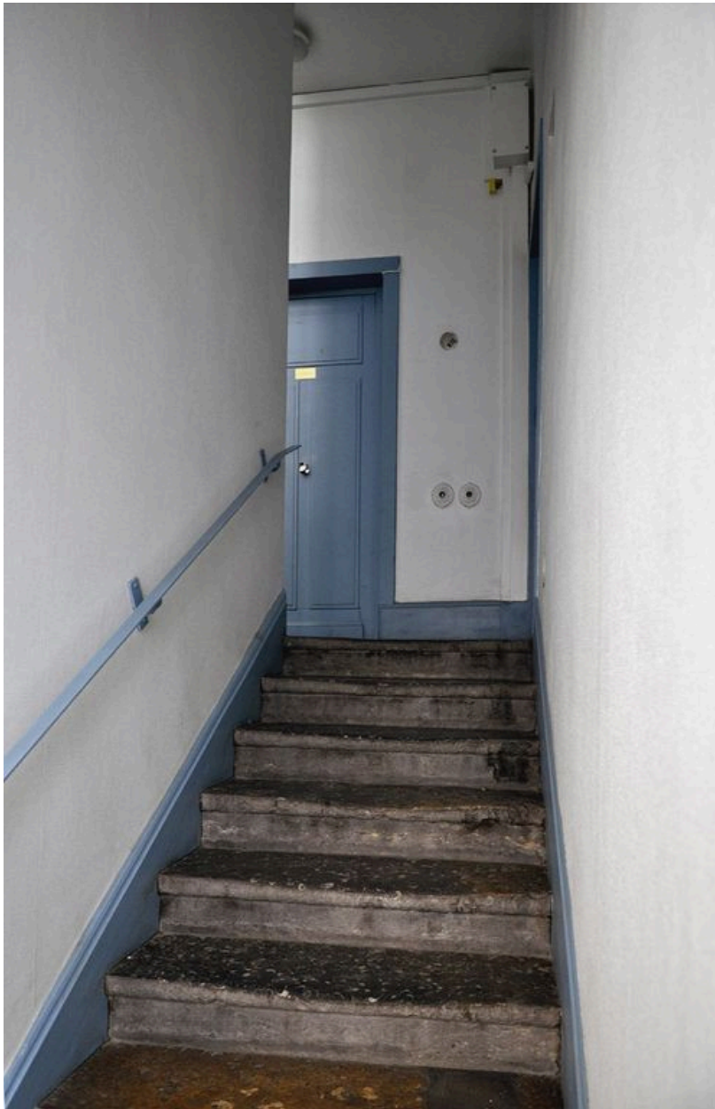
Cage d'escalier, vue depuis le repos vers le deuxième palier
