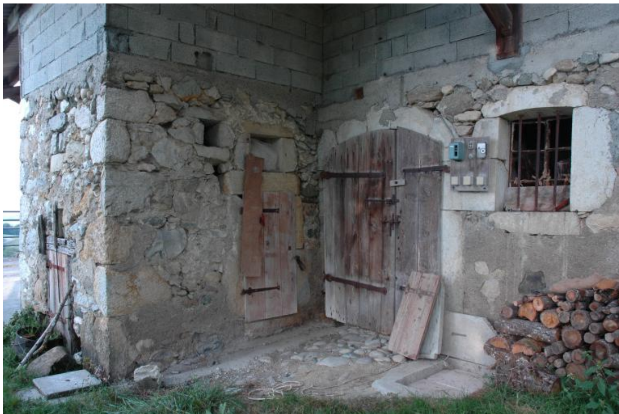
Détail de l'étable et de la loge à porc.
